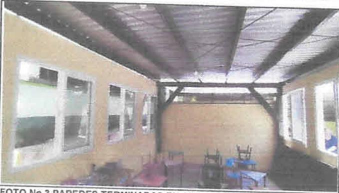
FOTO No.3 PAREDES TERMINADAS EN AULA CON ACABADO FINAL DE REPELO Y CERNIDO
