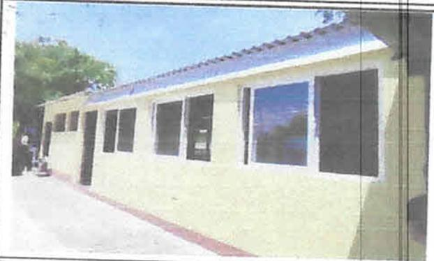
FOTO No. 2 VENTANAS DE PVC INSTALADAS Y CAMBIO DE TECHO REALIZADO
